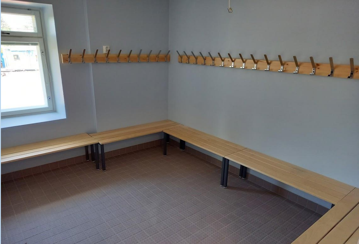
Kuva 3. Saneeraus 362 pukutila 2 ja 361 pesutila 2
