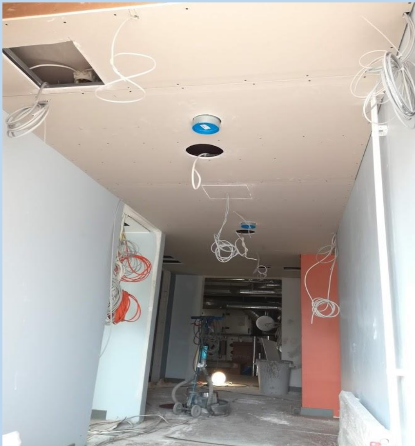
Kuva 2. Saneeraus, umpikipsi alakattojen umpeen laittaminen
