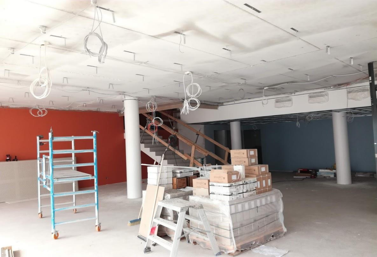
Kuva 2. Saneeraus, umpikipsi alakattojen umpeen laittaminen
