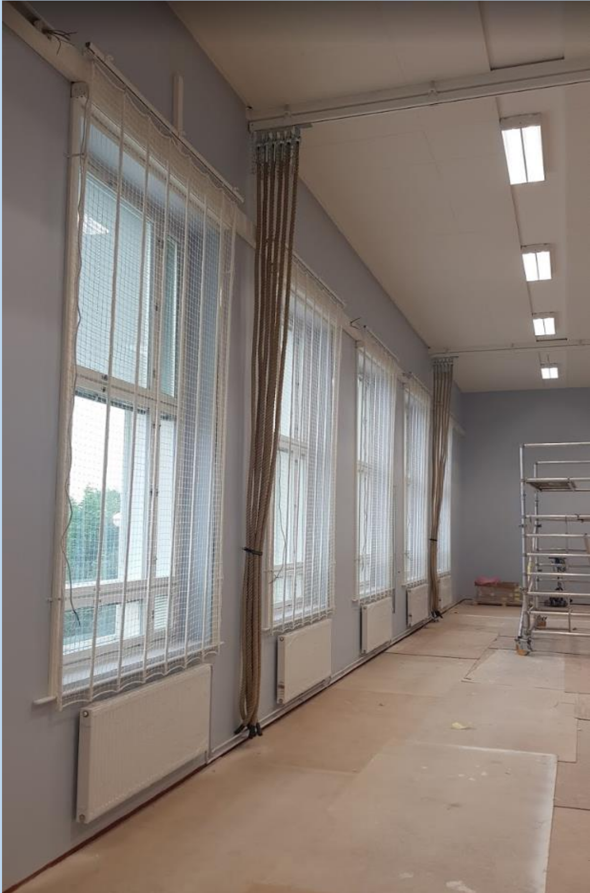
Kuva 3. Pimennysverhot ja pallonsuojaverkot asennettu
