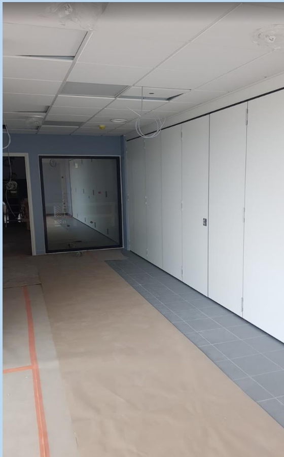
Kuva 2. Taiteovien asennus käynnissä
