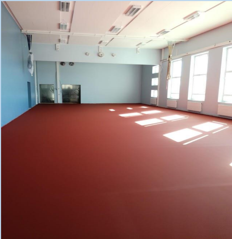
Kuva 2. Liikuntasali, Pulastic lattiapinnoite valmis
