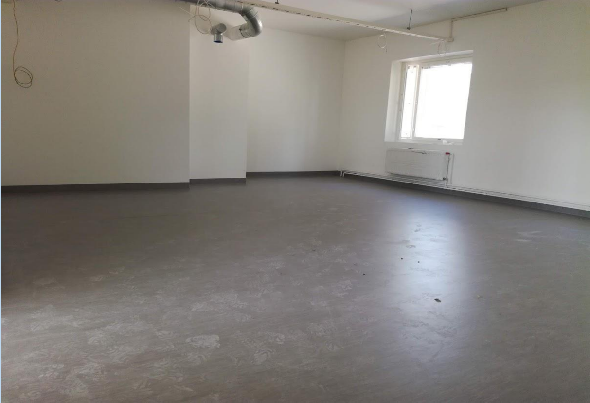
Kuva 2. Liikuntasali, Pulastic lattiapinnoite valmis
