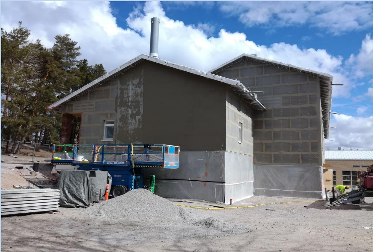
Kuva 4. Rappaukset käynnissä
