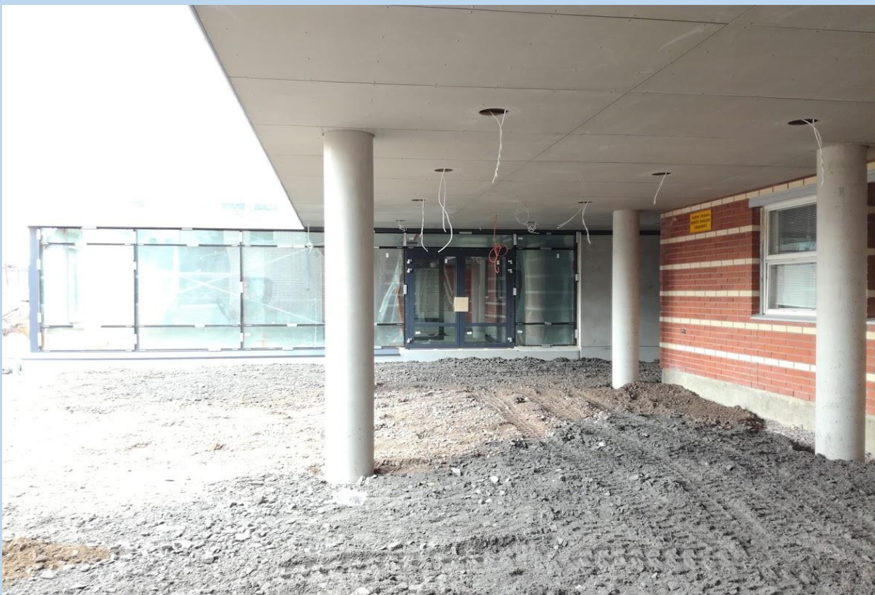
Kuva 4. Alapihan alumiini ulko-ovet asennettu
