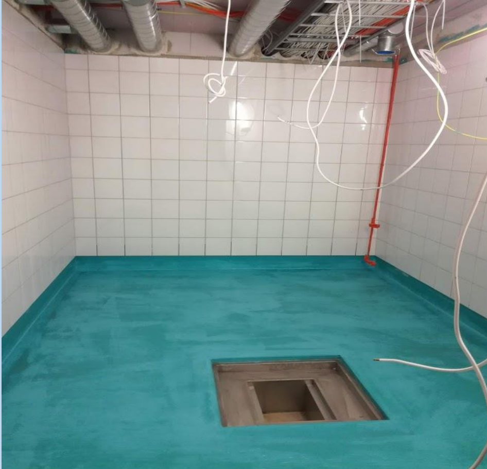
Kuva 2. Saneeraus, siivoushuoneen laatoitustyöt
