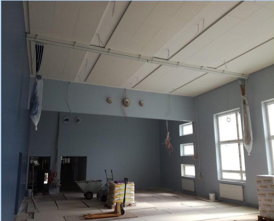
Kuva 3. Saneeraus, Liikuntasalin köydet asennettu
