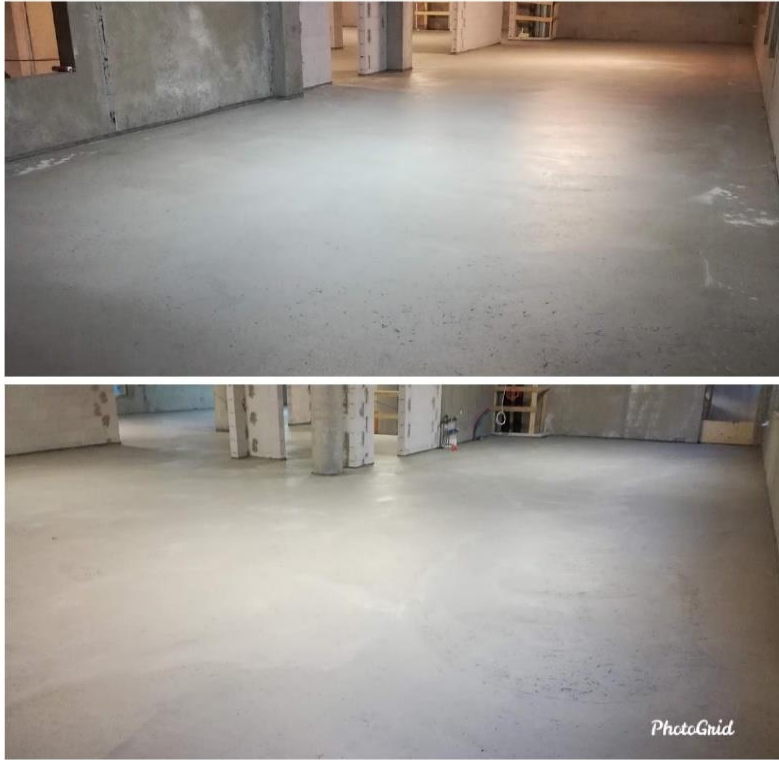
Kuva 2. Saaneeraus, Sähkökeskuksen epoksilattia 223
