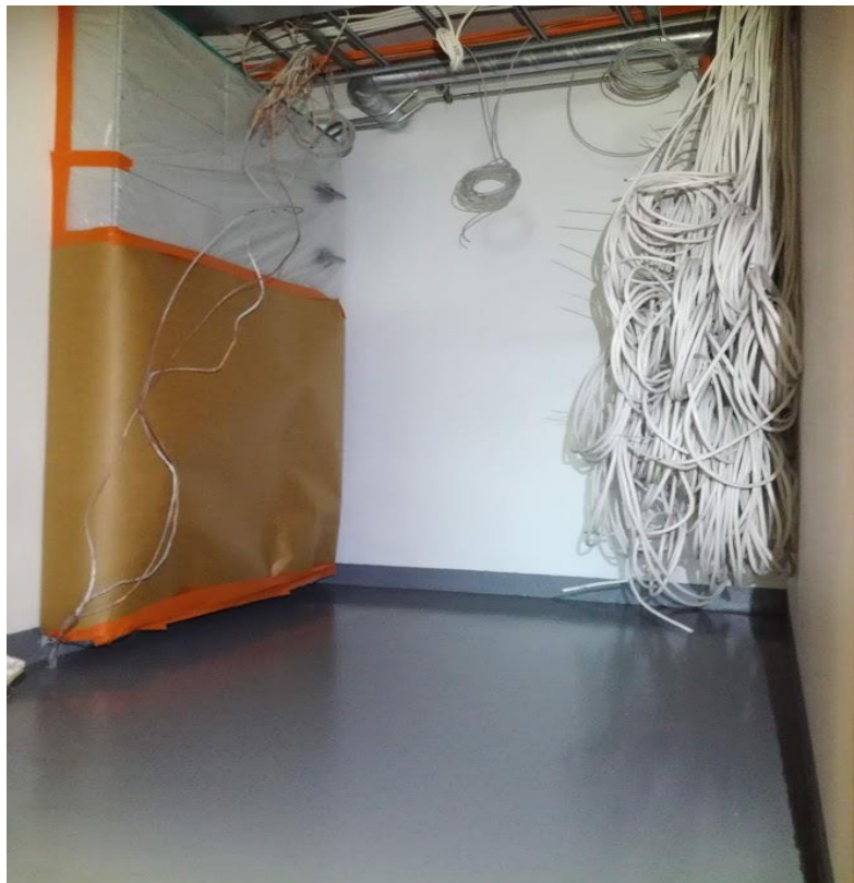
Kuva 2. Saaneeraus, Sähkökeskuksen epoksilattia 223
