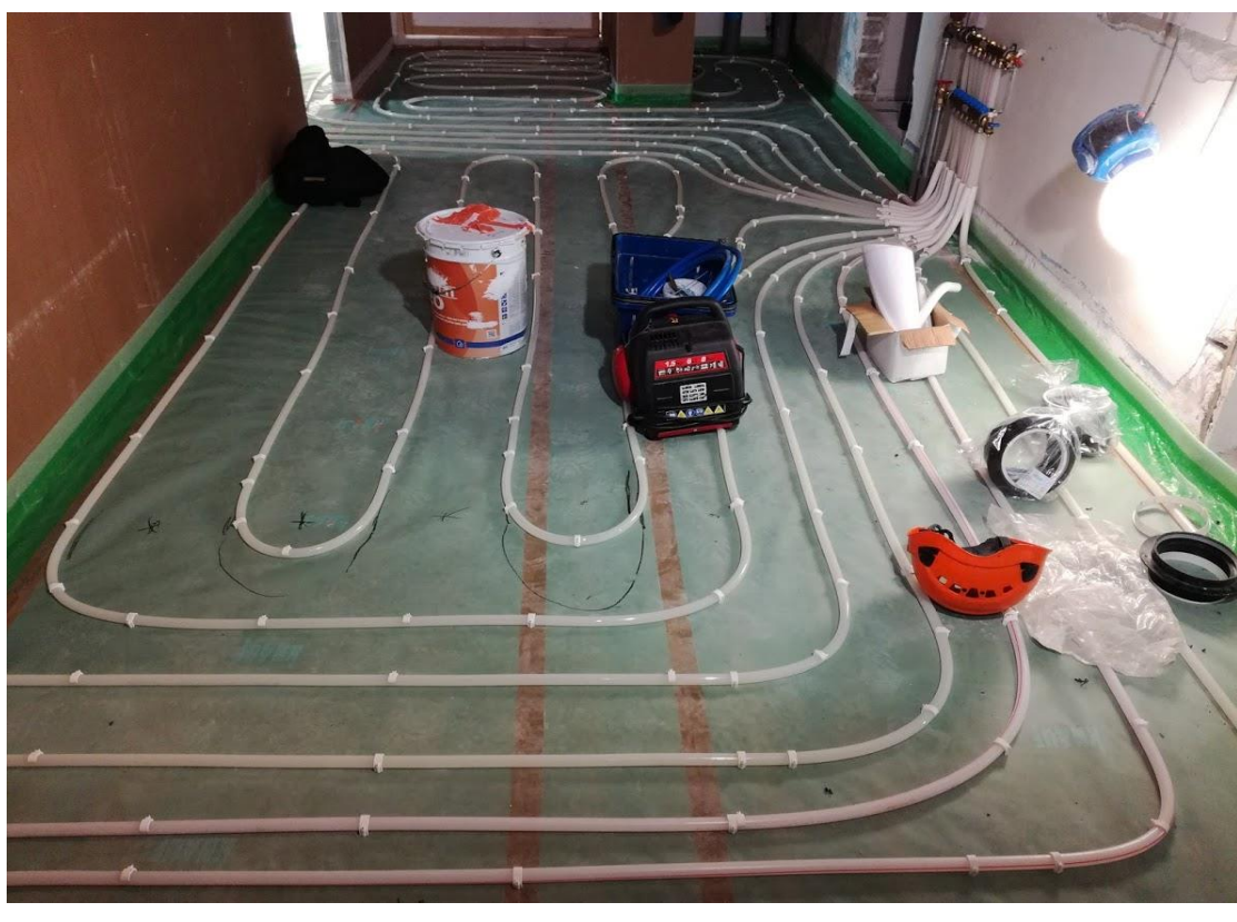
Kuva 3. Saneeraus, ulan lattialämmitys
