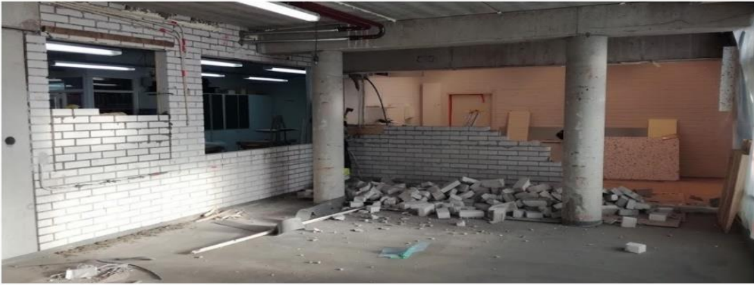
Kuva 3. Laajennusosa, Yhdyskäytävän seinän tuhoaminen
