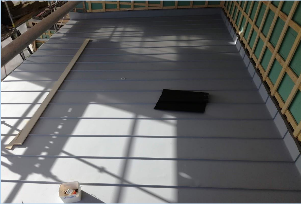
Kuva 3. Laajennusosa, Yhdyskäytävän peltikatto
