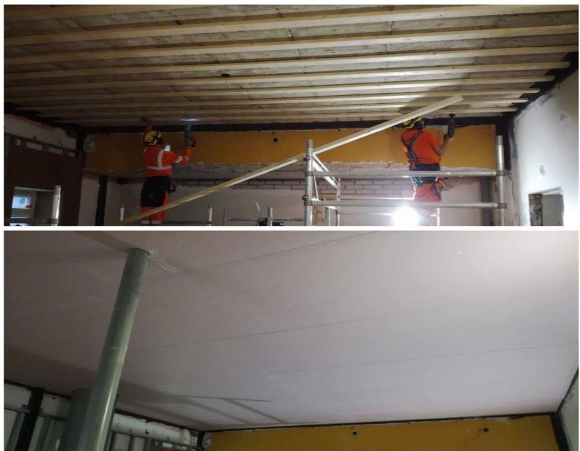
Kuva 4. Saneerausosan aulan katon levytys
