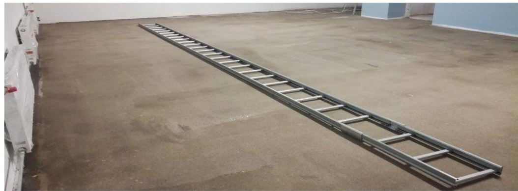
Kuva 1. Saneerausosan pienryhmäntilan ja perhekeskuksen lattian epoksi
