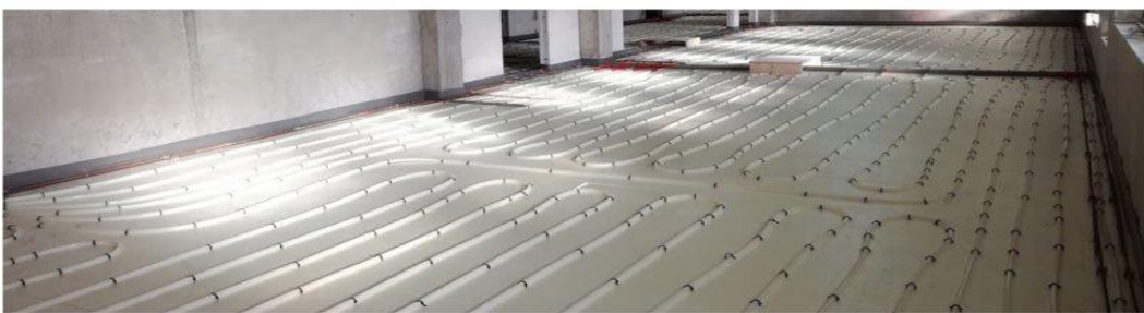
Kuva 2. 2.krs lattialämmityksen asennus
