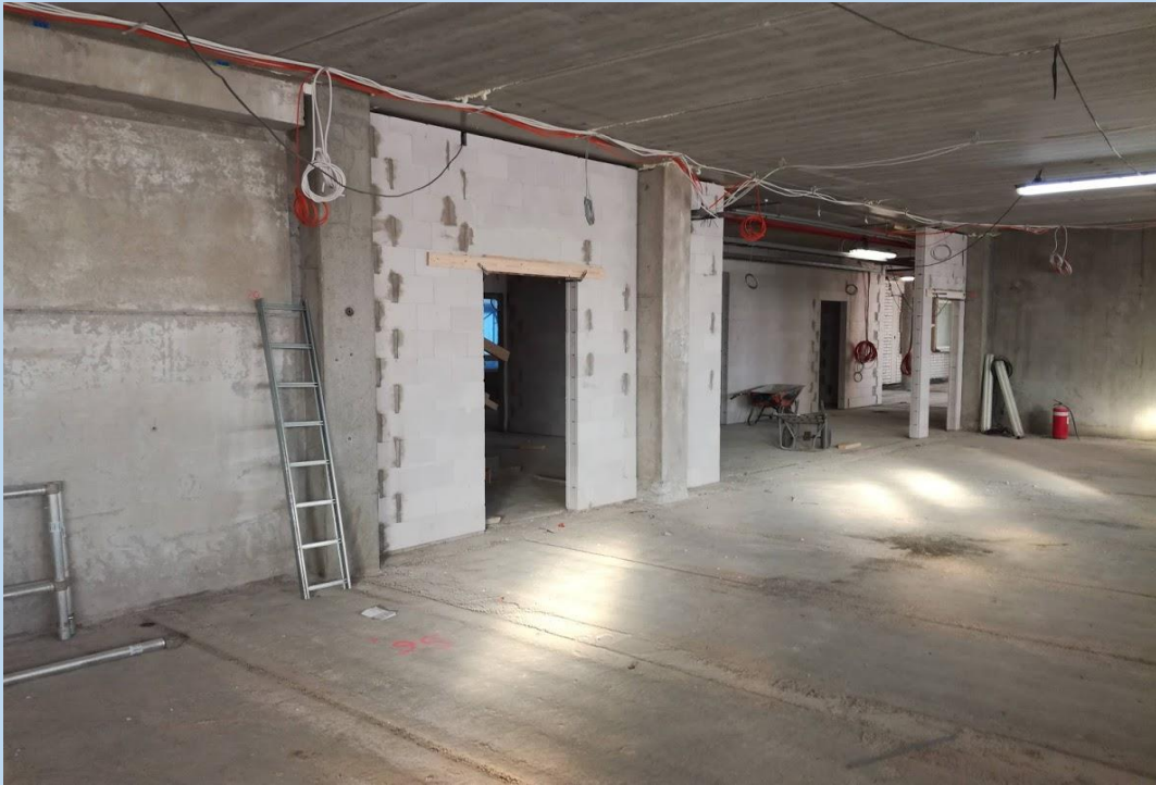
Kuva 3. Laajennusosan, 2.kerroksen väliseinien muuraus
