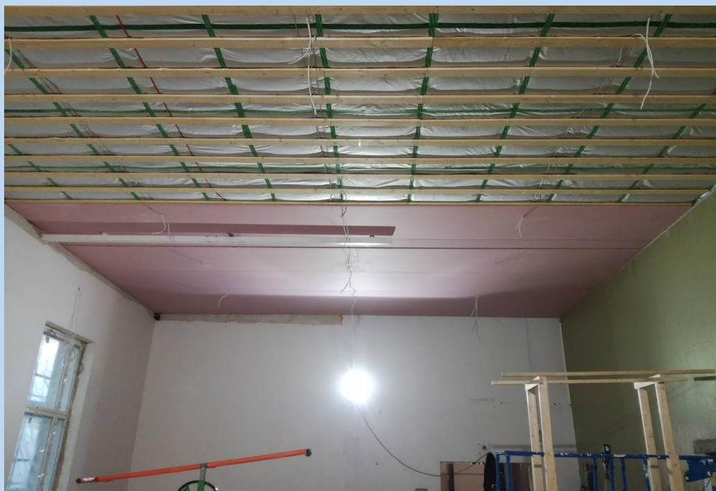
Kuva 1. Saneerausosan liikuntasalin katon levytys
