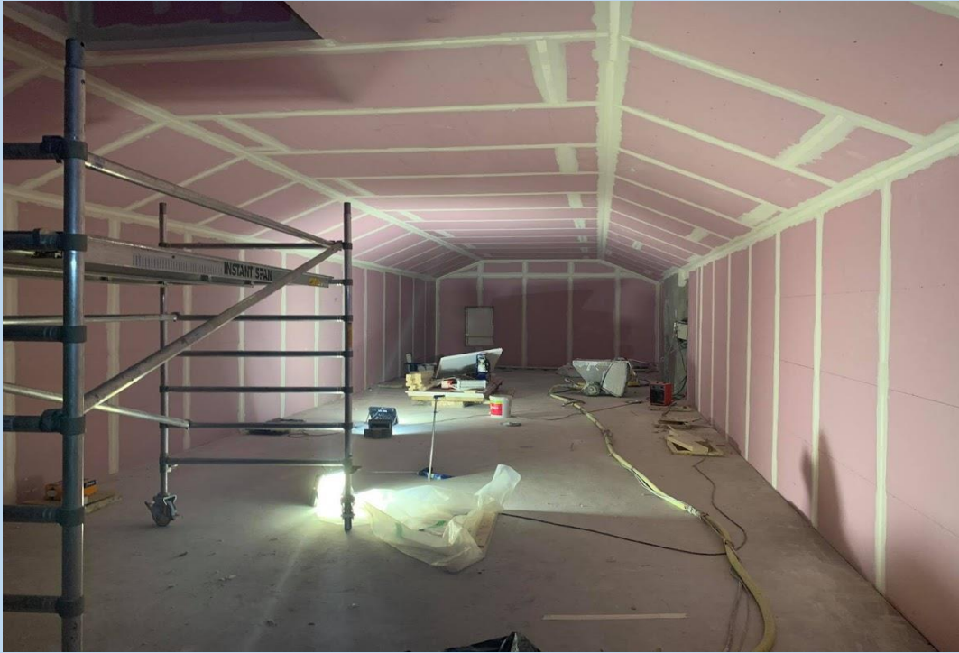
Kuva 4. Saneerausosan liikuntasalin seinien hionta käynnissä
