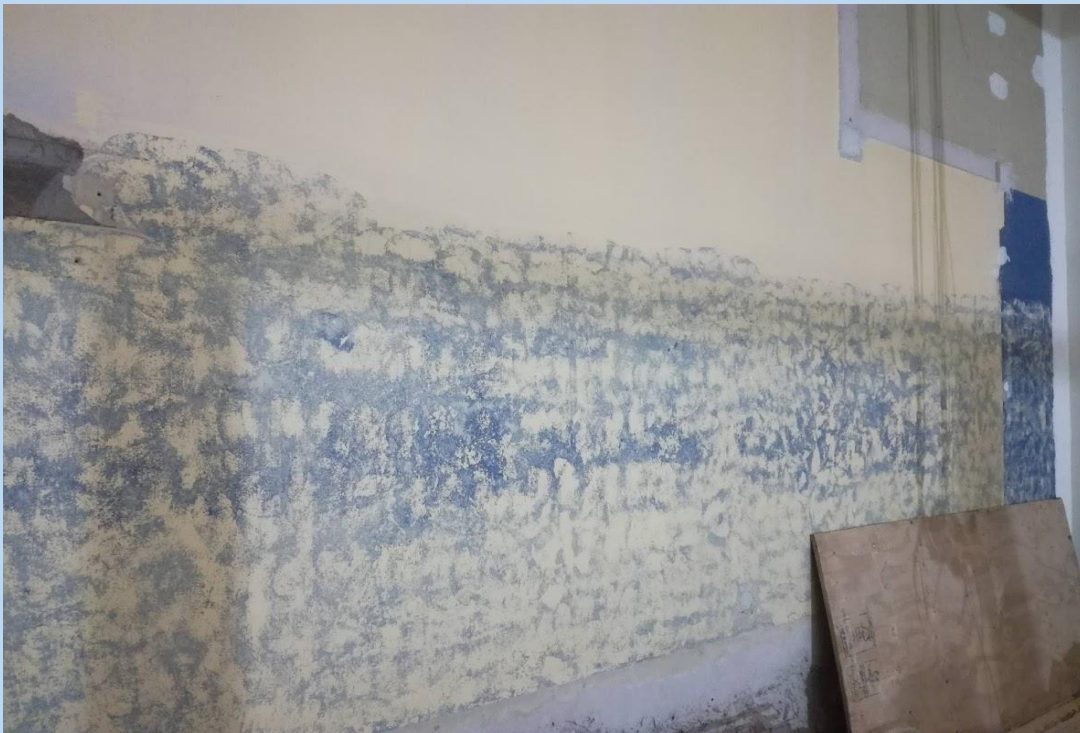
Kuva 4. Saneerausosan liikuntasalin seinien hionta käynnissä
