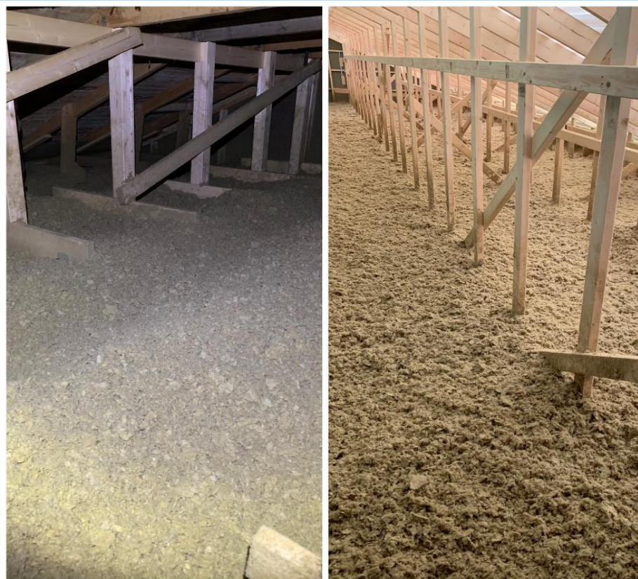
Kuva 4. Saneeraus, yläpohjan puhallusvilla
