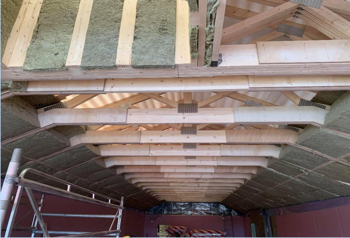
Kuva 3. Laajennusosan IV-konehuoneen katon villoitus
