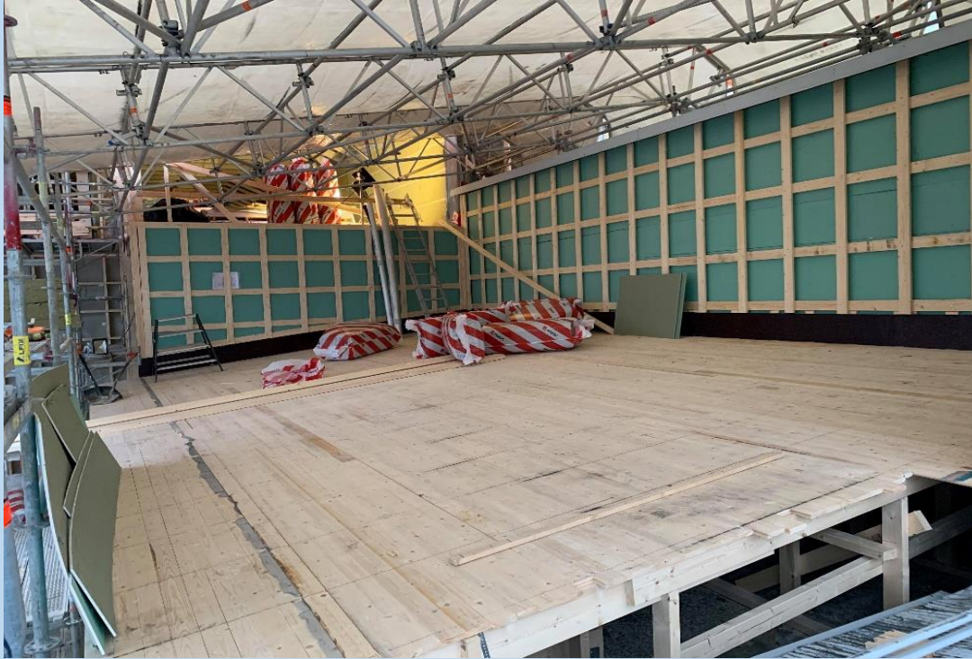
Kuva 3. Yhdyskäytävän vesikaton puutyöt pääosin valmit
