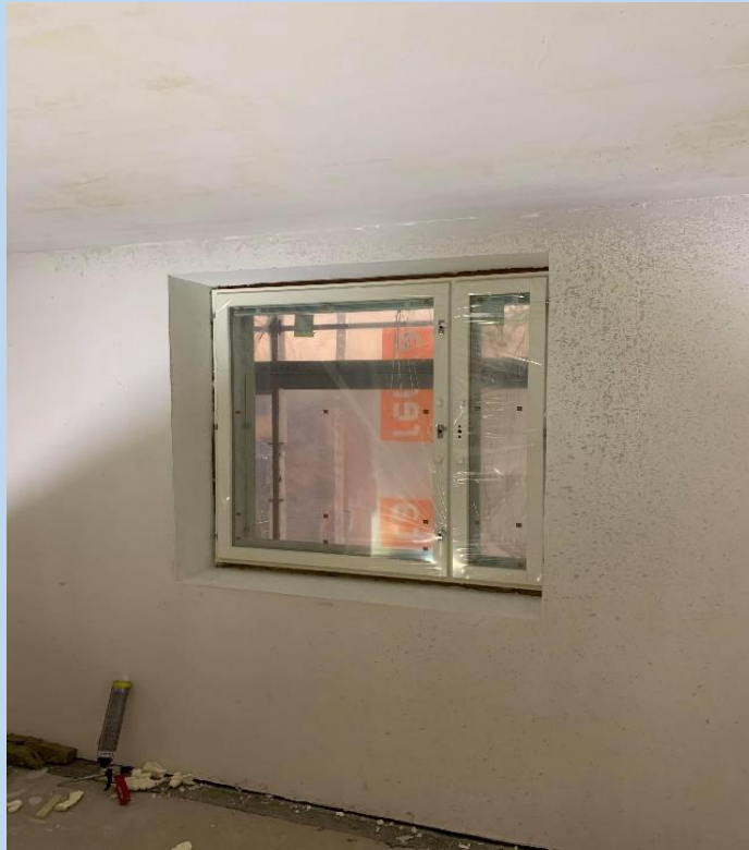
Kuva 2. Saneerausosan julkisivun tuulensuojalevytyt
