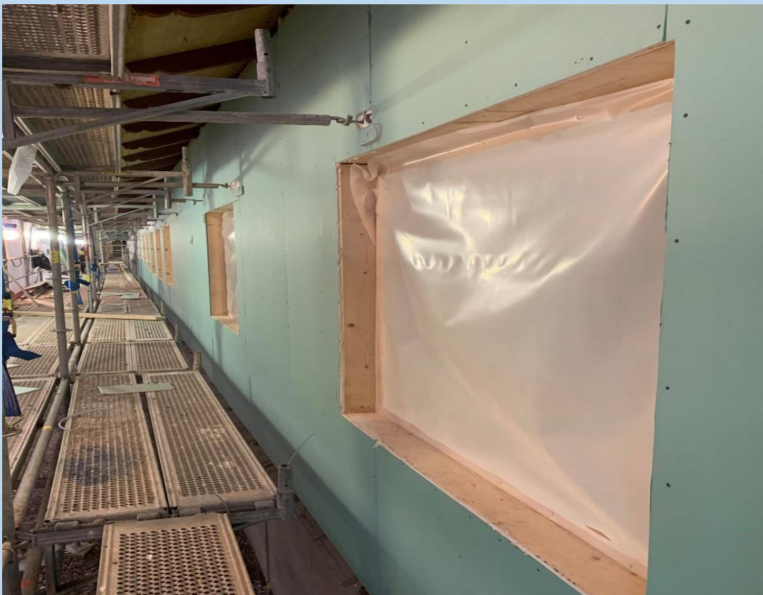
Kuva 2. Saneerausosan julkisivun tuulensuojalevytyt
