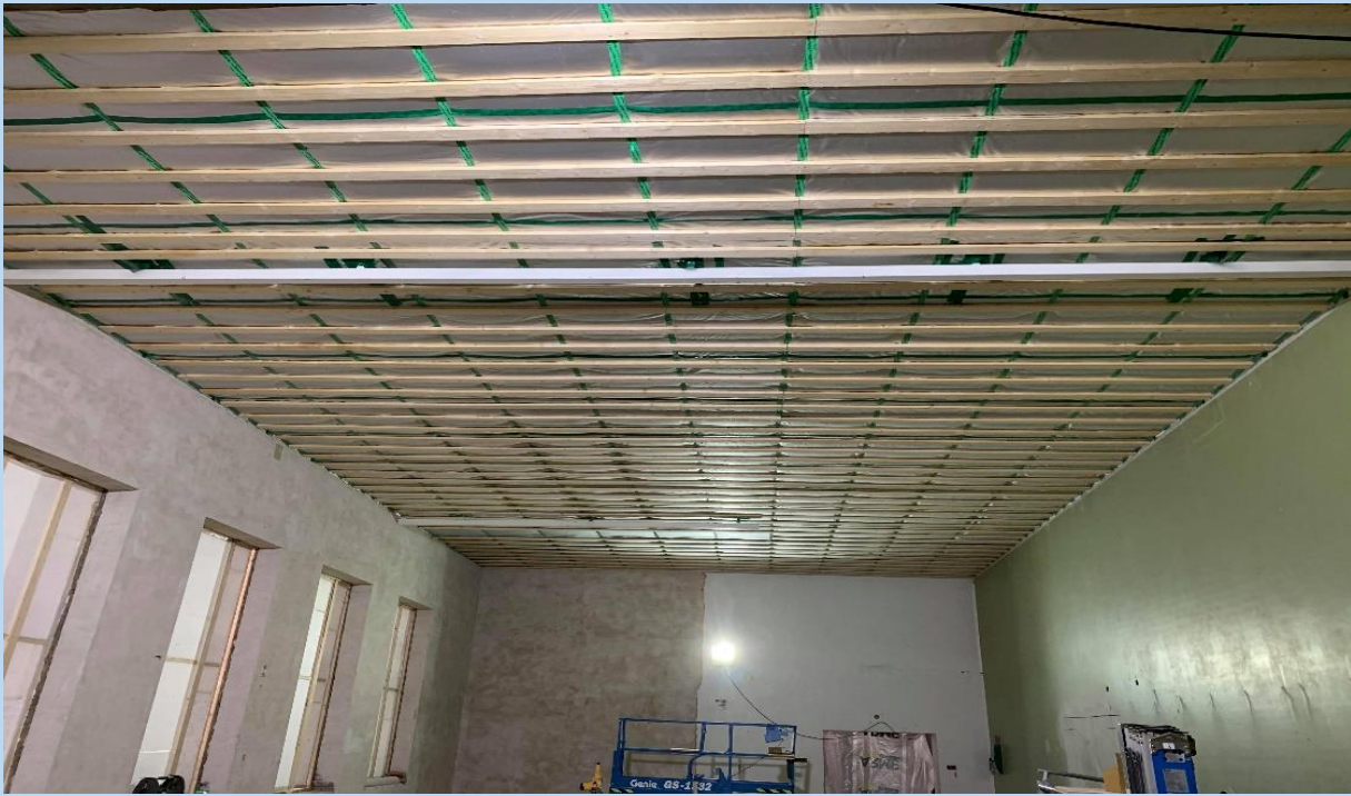
Kuva 1. Saneerausosan liikuntasalin alakaton koolaus.
