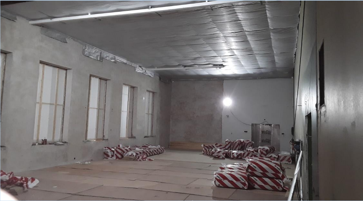
Kuva 1. Saneerausosan liikuntasalin alakatto villoitus ja höyrynsulku
