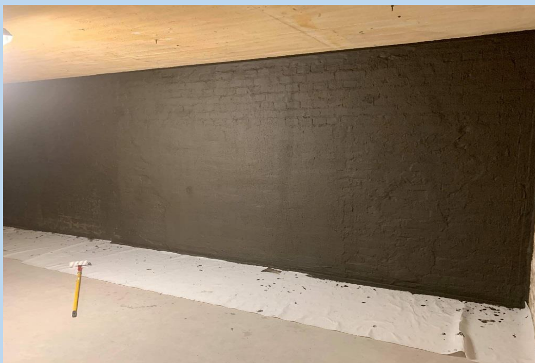
Kuva 2. Saneerausosan tuleva IV-konehuone, tiivistystyöt käynnissä
