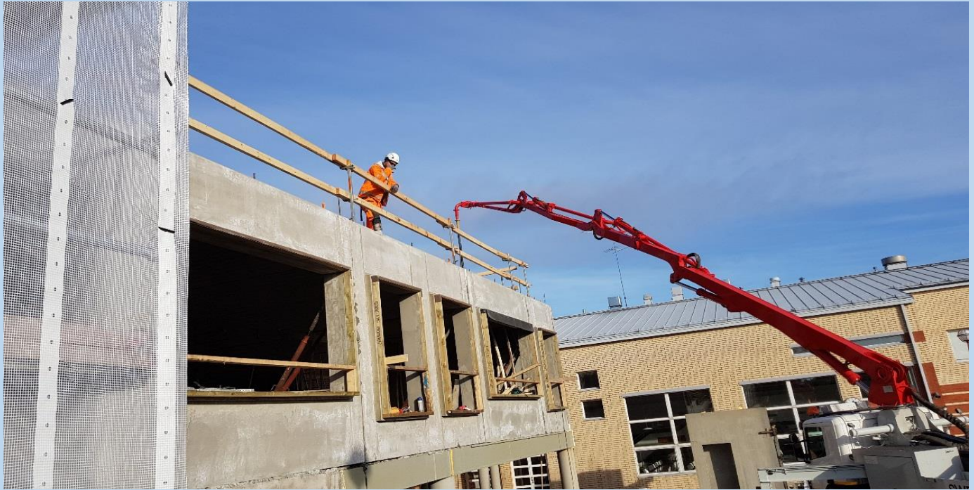
Kuva 1. Ontelosaumavalu käynnissä 2.kerros katto
