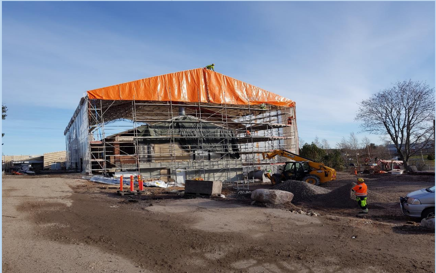
Kuva 2. Säätösuojan telineiden asennus käynnissä
