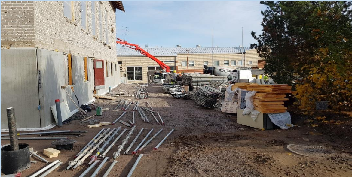
Kuva 2. Sääsuojan telineiden asennus käynnissä
