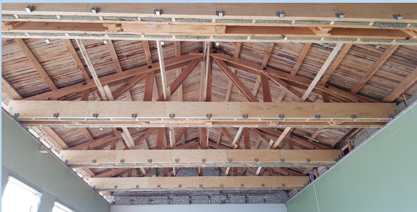
Kuva 1. Liikuntasalin yläpohjan vahvistusta
