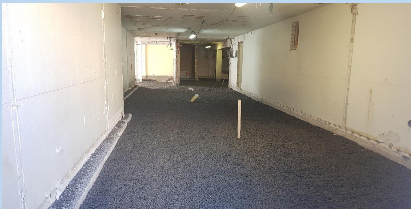
Kuva 2. Saneerausosan alapohjan kapilaarikatkosepelin asennusta
