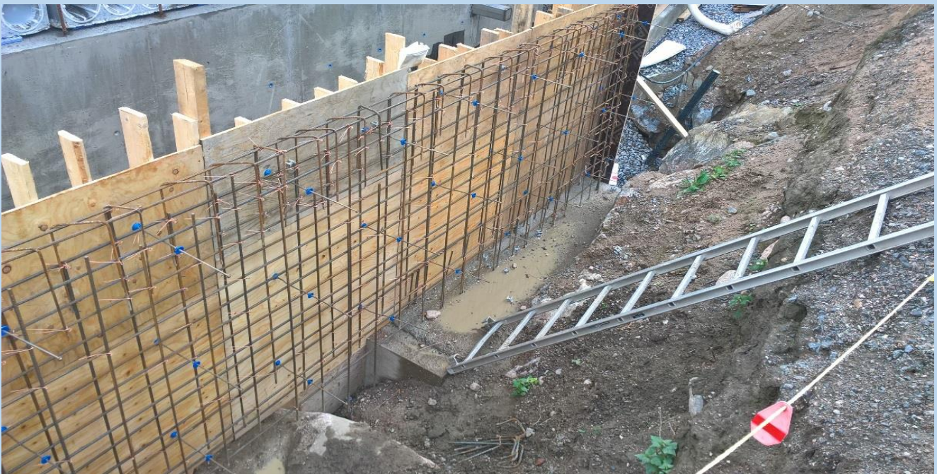
Kuva 2. Tukimuuri raudoitusta
