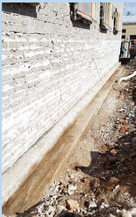
Kuva 1 ja 2. ulkoseinän sokkelin vierusta ja saneerausosan alapohjan maa-aineksen poisto
