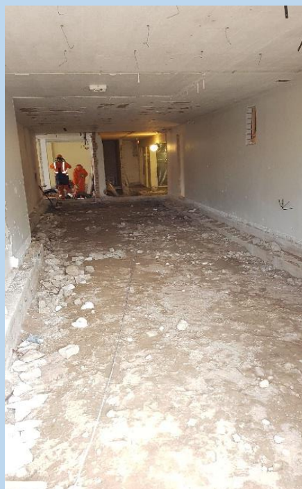
Kuva 1 ja 2. ulkoseinän sokkelin vierusta ja saneerausosan alapohjan maa-aineksen poisto
